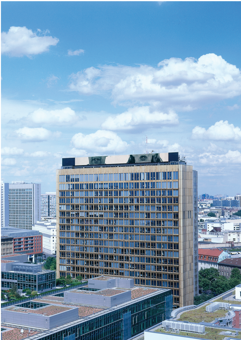
Installationsansicht, Axel Springer Hochhaus, Berlin
